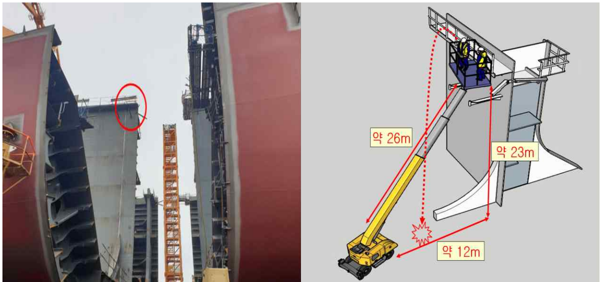
【사고발생 장소와 장비(고소작업대), 재해발생 높이】
